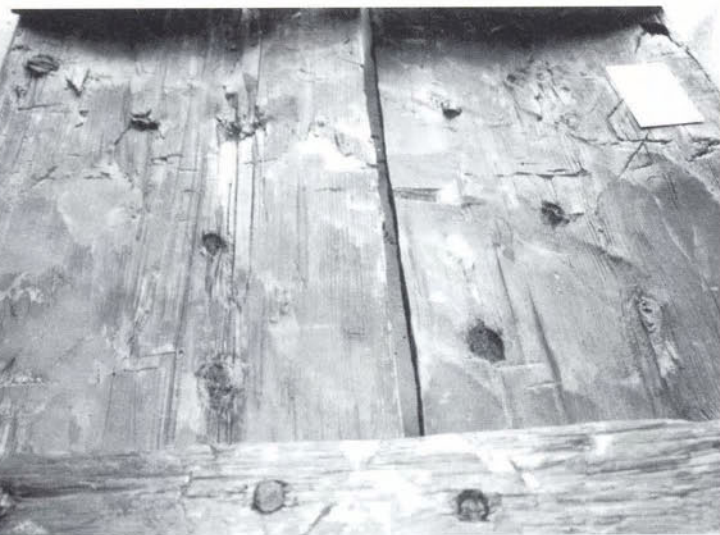
Afb. 4. Hak- en disselsporen op planken. (Foto: auteur)
